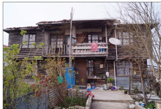
Fig. 19. Yalı Baskısı sheathing on a timber framework system, Şile (Author)
