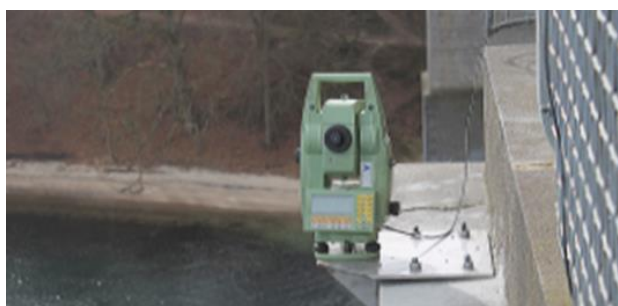
Fig. 5.1.12 Exemplu de utilizare a sistemului LIFA Monitoring Solution în supravegherea clădirilor [117]
