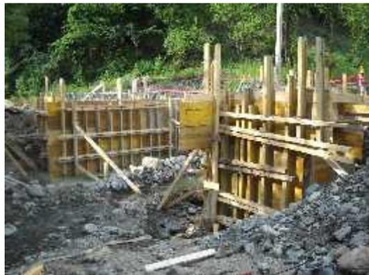
Fig. 8. *End column concreting*
